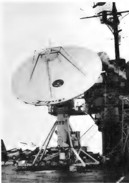
Bei der Direktübertragung wurde mit diesem 9-m-Reflektor das Bildsignal vom Deck des Flugzeugträgers dem Synchron-Satelliten Early Bird übermittelt
